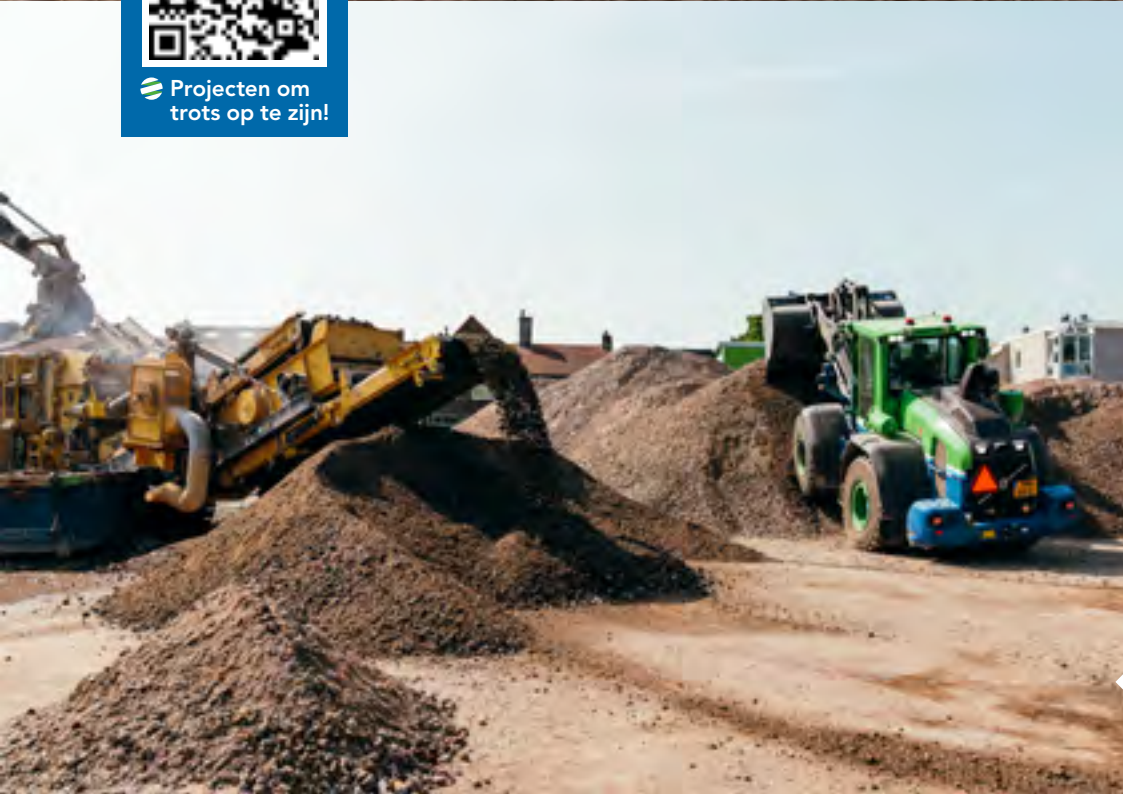
Project: Bloemistenlaan , Leiden Betonpuin breken en recycling 2022
